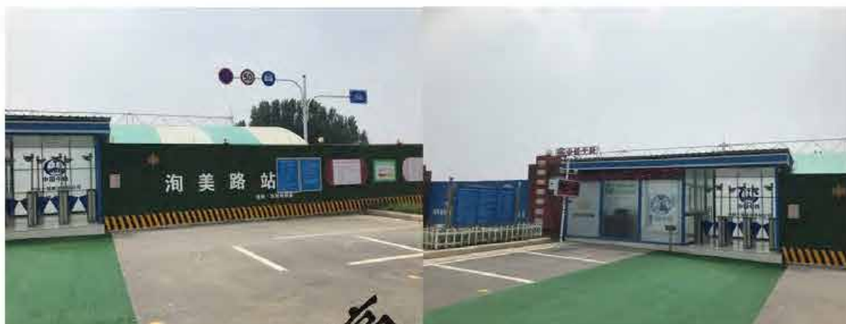
询美路站施工场地
