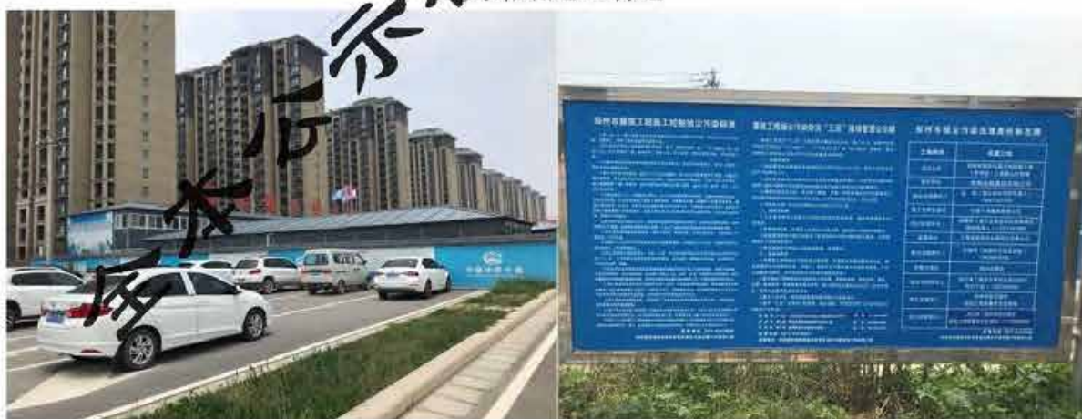
苑陵路站施工场地
